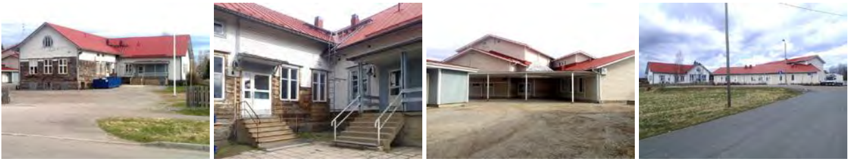
Alakoulurakennus ja sen laajennus. Vanhalla koululla on purkupäätös kosteusvaurioiden vuoksi.
