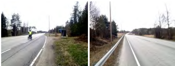
Valtatietä kylän pohjoisosan kohdalla.
